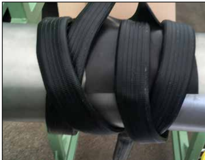
Slika 14: Tesnilna cev SAVA je ovita okoli poškodovanega predmeta
